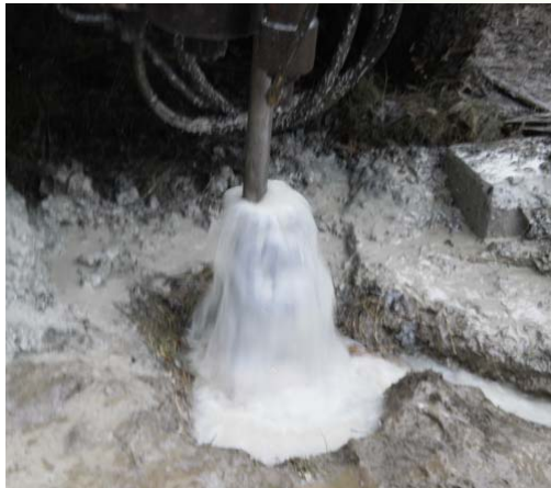
Уградња, испирање и обезбеђење пијезометарске констукције
