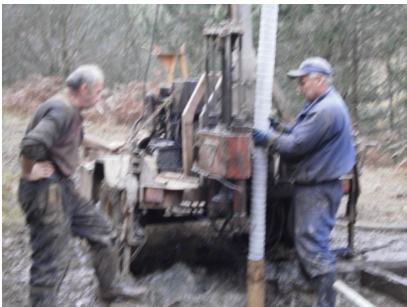
Уградња, испирање и обезбеђење пијезометарске констукције
