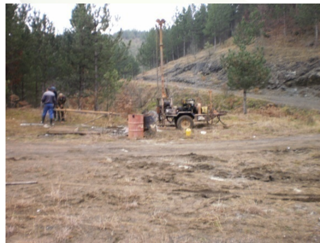
Истражно бушење на локацији Змајевац
