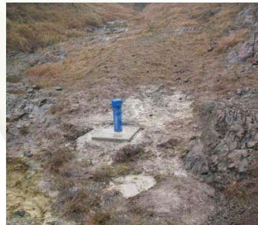
Уградња, испирање и обезбеђење пијезометарске констукције
